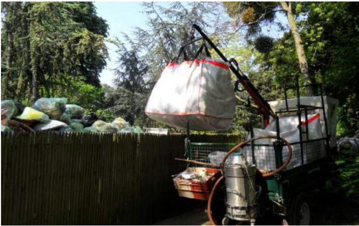
Fig. 2 : Vidange de la remorque dans une benne (reprise au camion)
